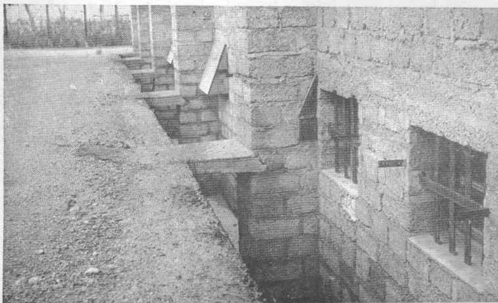
Fenêtres occultées du Bunker.
