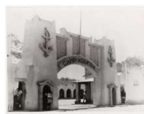
Entrée du Quartier du RTST
