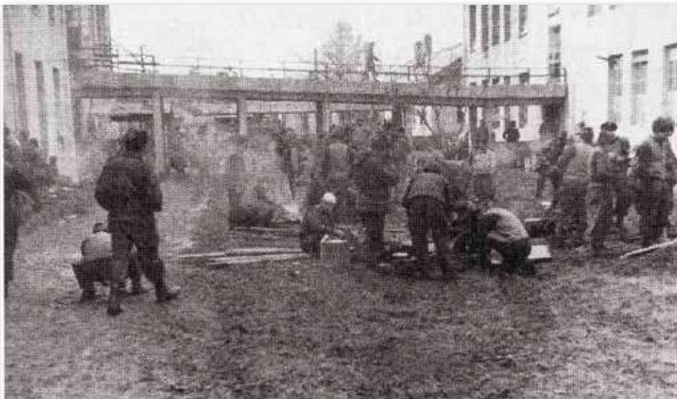
Le bataillon s'installe dans l'école d'agriculture de SUWON fortement endommagée (Photo Gérard JOURNET)
