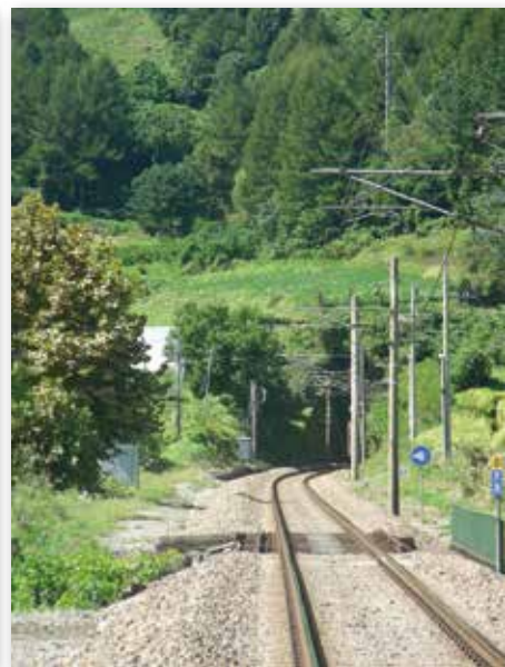
Le tunnel côté Ouest
