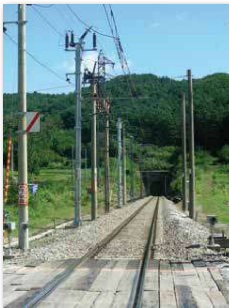
Le tunnel côté Est
